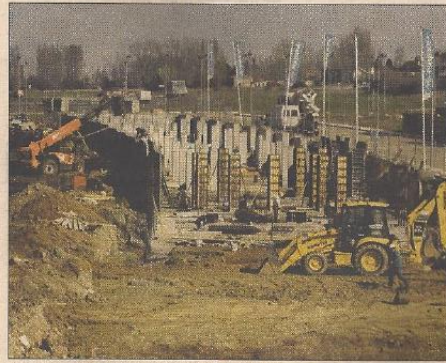
Viviendas en construcción en Salamanca.
